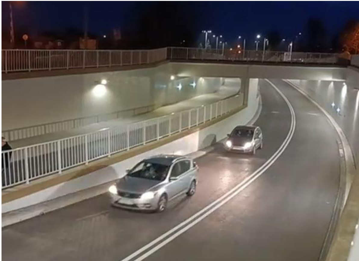
Wiadukt kolejowy – droga dołem na poziomie -1
