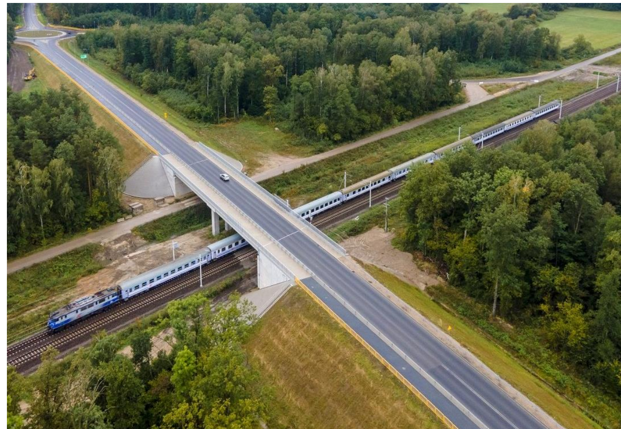
Wiadukt drogowy – droga górą na poziomie +1
